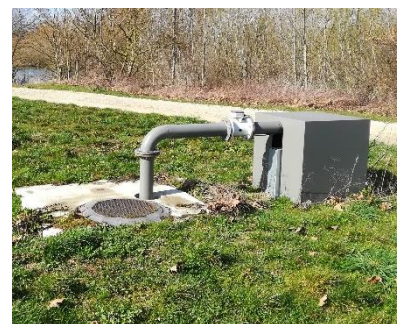
Figure 3: exemple de forage
